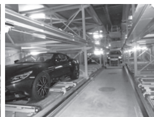
立体駐車装置
