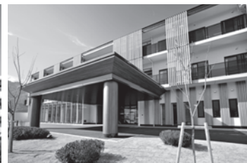
特別養護老人ホーム しそうの杜 (平成27年3月竣工)
