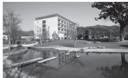
宍粟市庁舎(平成21年3月竣工)
