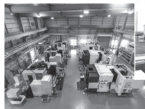
飾磨工場 機械設備
