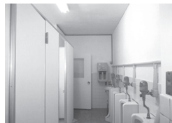
トイレ、内壁施工例
