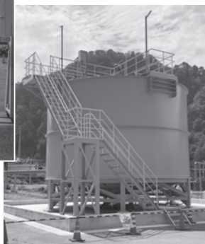
澱物貯槽タンク製作・設置工事
