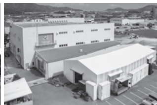
姫路第一工場外観
