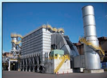
KJバグフィルタ (ろ過式集じん装置)
