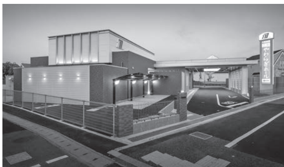
施工事例：二見大和会館やわらぎホール
