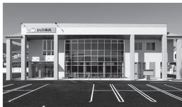
施工事例：JA兵庫西 龍野誉田支店
