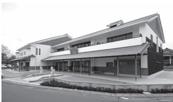
施工事例：あばしまち交流館
