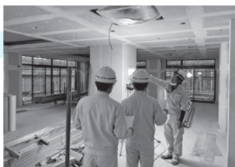
現場作業風景
